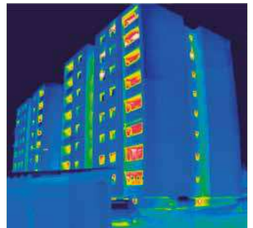
Warmteverlies na renovatie
